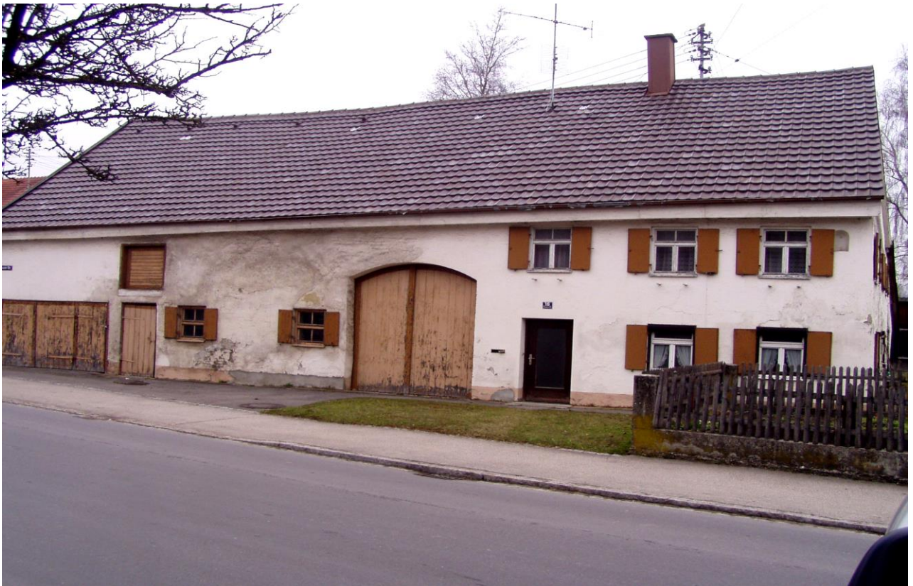
Tussenhauser Straße 16 (alte Hausnummer 12)
