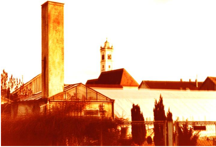
Zu einem Gewächshaus gehörte auch ein Kamin, da man bei entsprechender Witterung heizen musste. Um 1930
